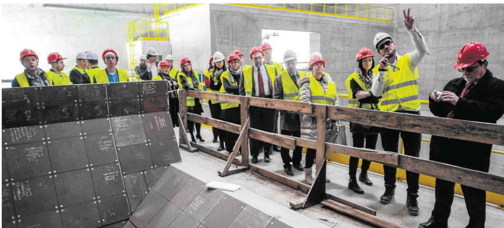
► Plac budowy spalarni śmieci przeżył wczoraj prawdziwy najazd gości - uczestników konferencji samorządowej „Termiczne przekształcanie odpadów komunalnych - nowoczesny system gospodarki odpadami”. Wśród nich byli samorządowcy z okolicznych gmin, naukowcy
