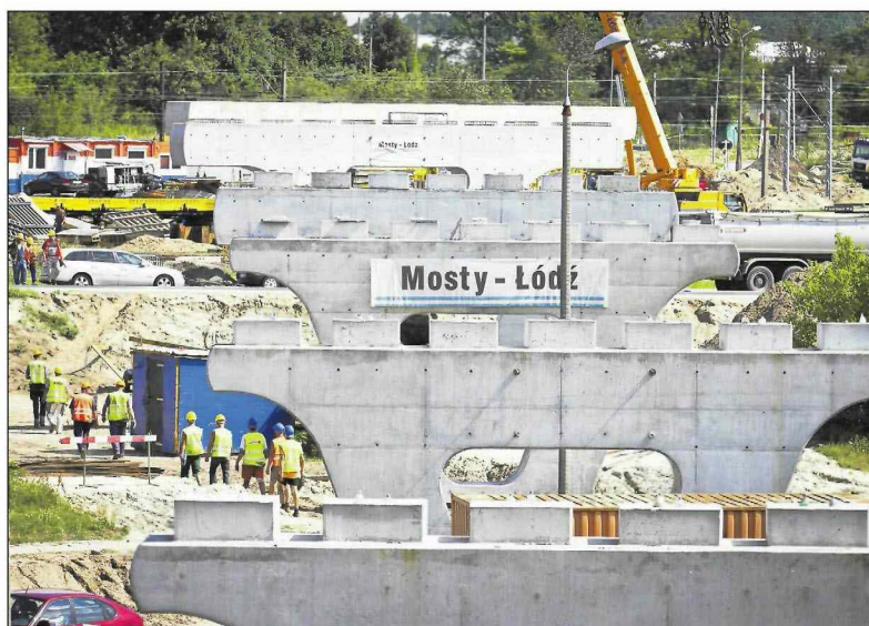
W rankingu „Rzeczpospolitej” nie ujęto budowy linii tramwajowej do Fordonu. Gdyby tak się stało, wypadlibyśmy w zestawieniu lepiej. FOT.: T. CZACHOROWSKI
