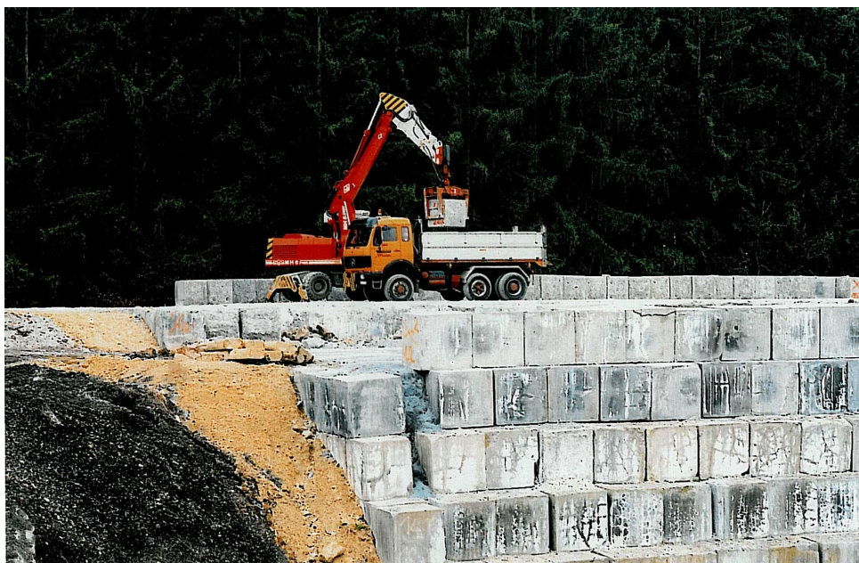
Rys. 19. Deponowanie zestalonych pozostałości z odpylania spalin i pyłów lotnych z kotła
