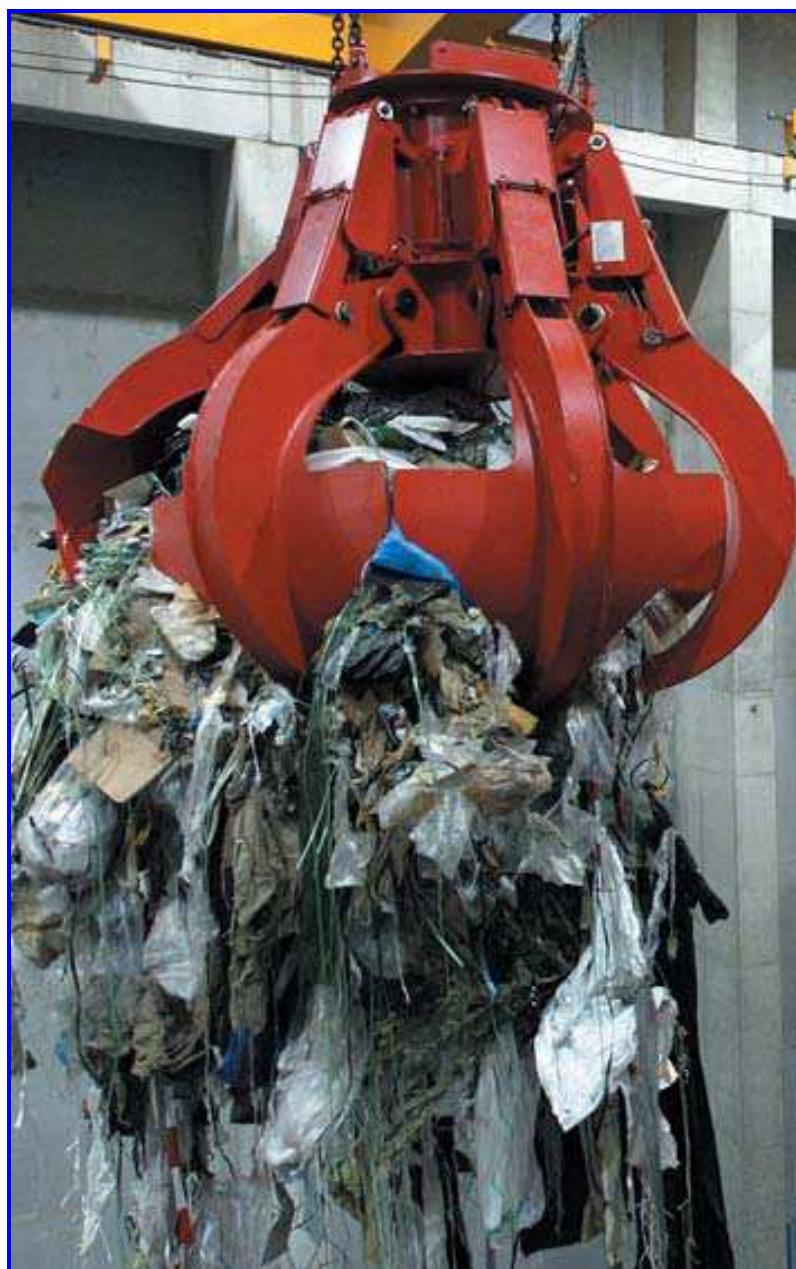
Ładunek odpadów do spalania
